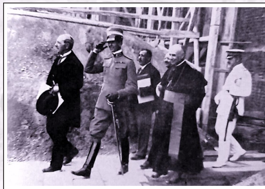
Umberto di Savoia visita il cantiere per la ricostruzione del Duomo di Messina accompagnato dall'arcivescovo Angelo Paino (1927)
